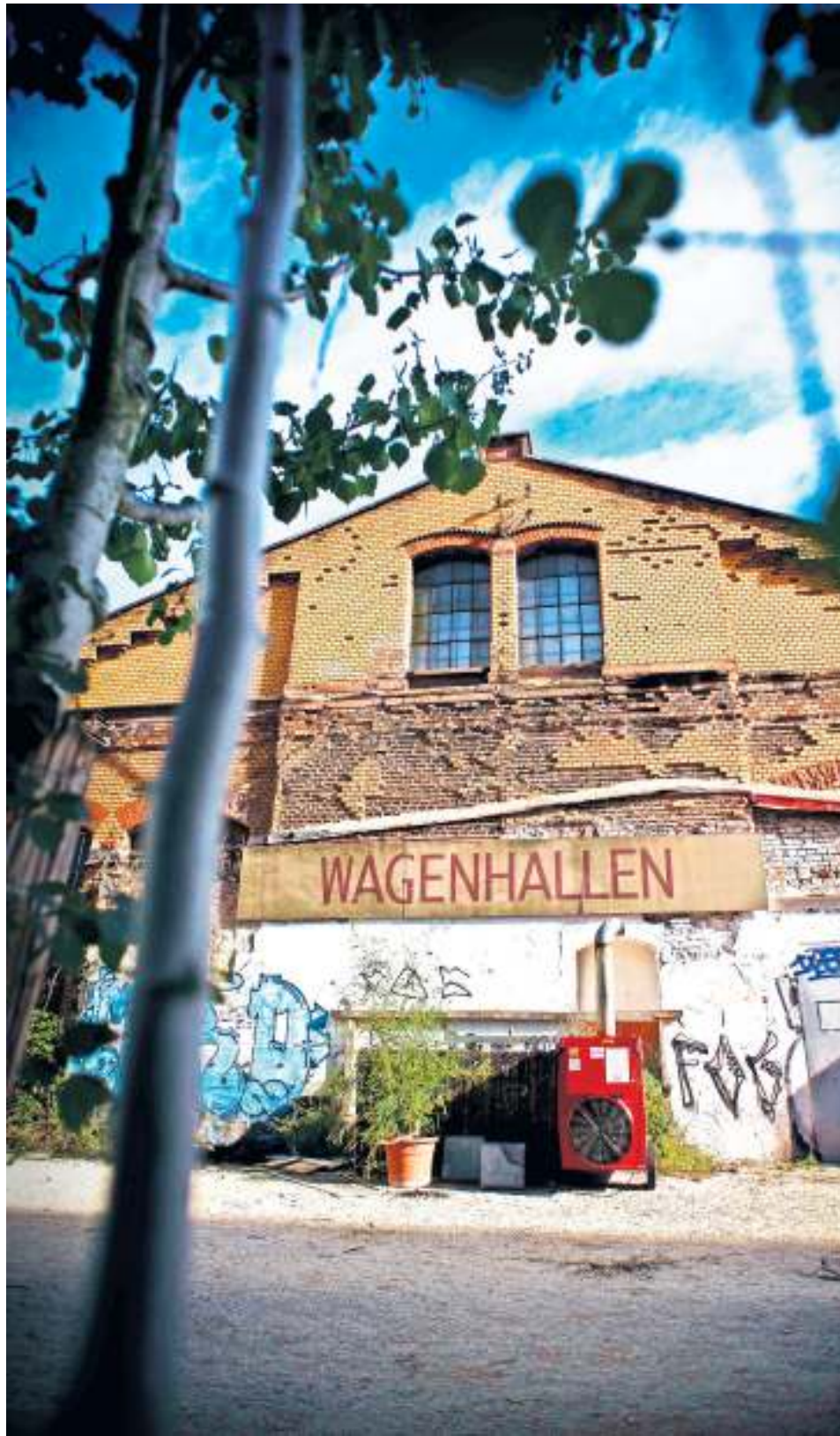
Die Wagenhallen werden mit großem Aufwand saniert.
